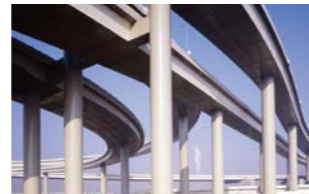
高速道路橋脚
